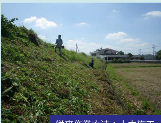
従来作業方法：人力施工
