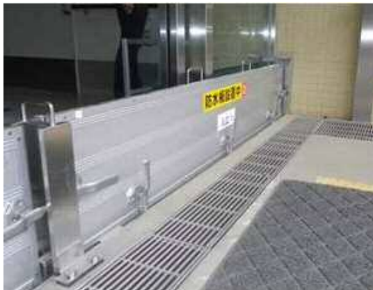
止水板設置状況写真
