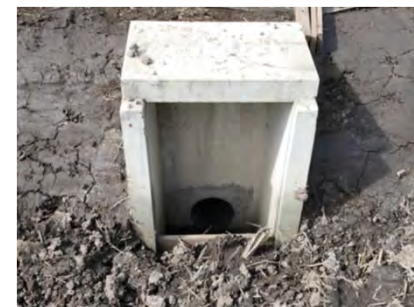
落水口の整備
