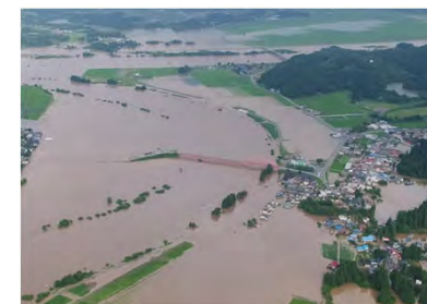
本川からの浸水状況
