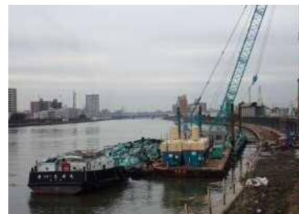
地盤改良の様子(隅田川)
