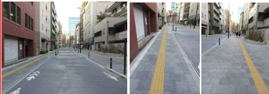
透水性舗装 整備状況写真
