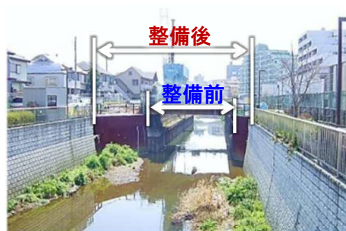
護岸整備・河道拡幅（石神井川）
