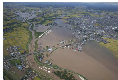
合流部での浸水状況
