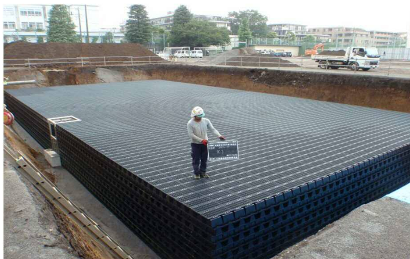
武蔵野市立第一中学校 雨水貯留施設施工状況
