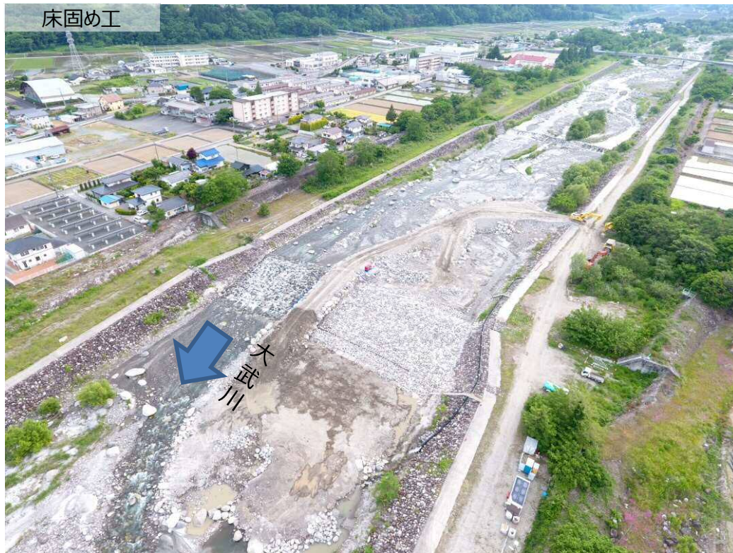
下流側より上流全景撮影
