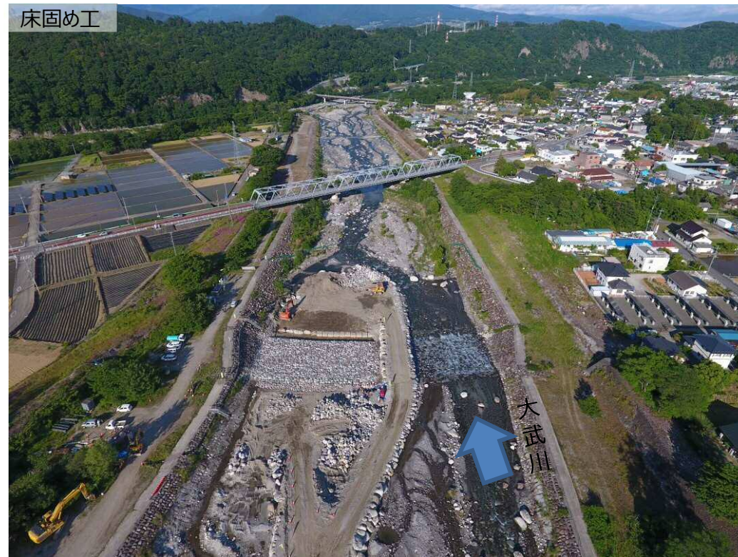
上流側より下流全景撮影
