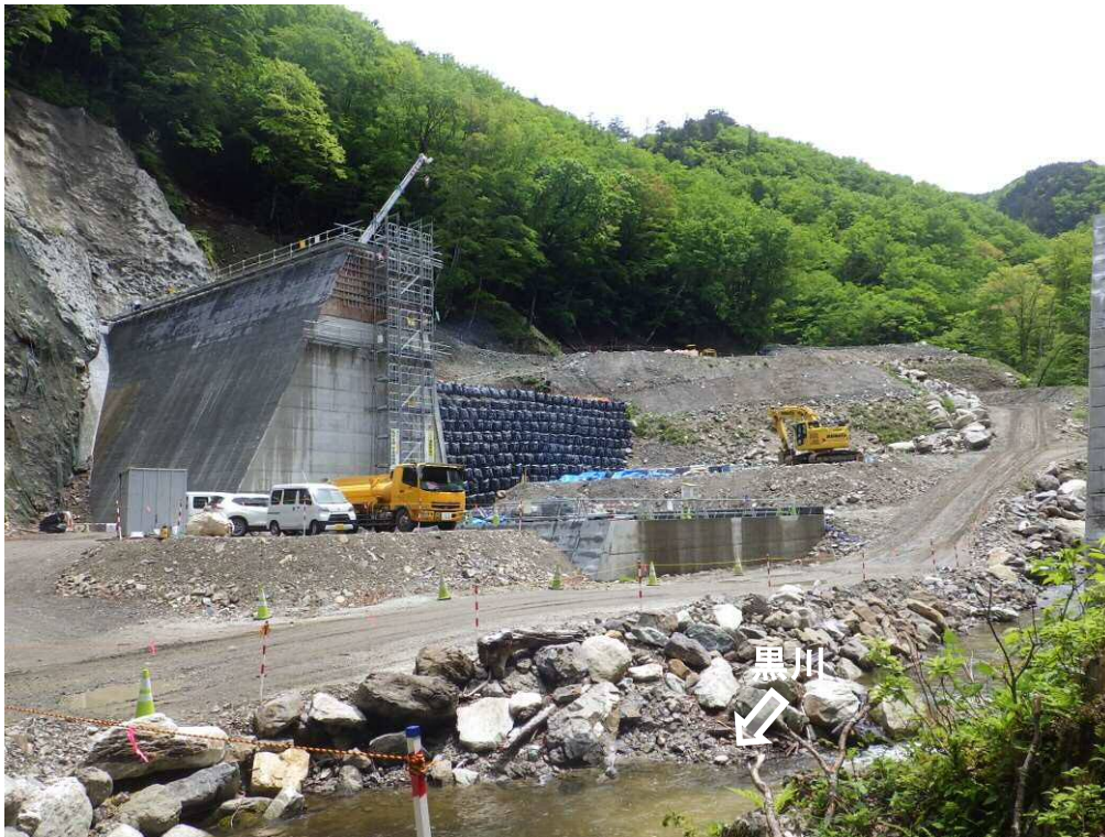
下流より本堰堤を望む（コンクリート堰堤工）
