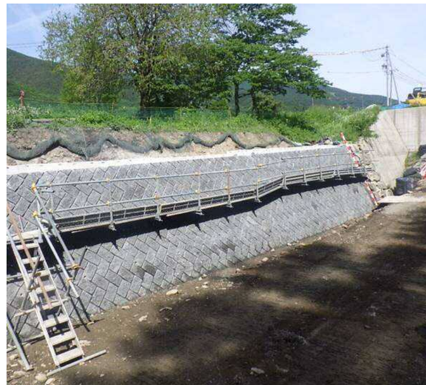
下流より施工箇所を望む（流路護岸工 補修箇所）
