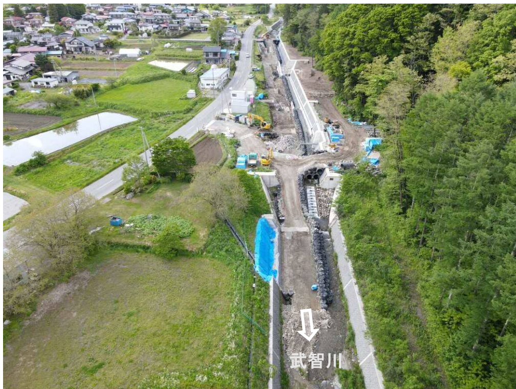
下流上空より 施工箇所（全景）を望む
