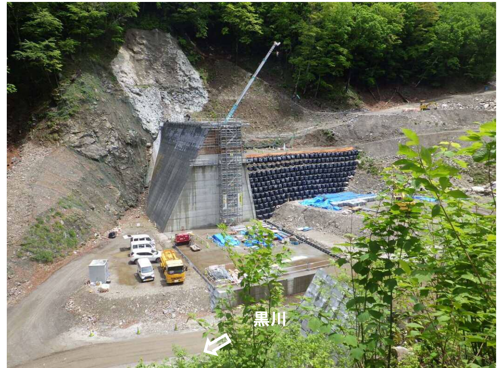
下流 左岸上部より本堰堤を望む（コンクリート堰堤工）
