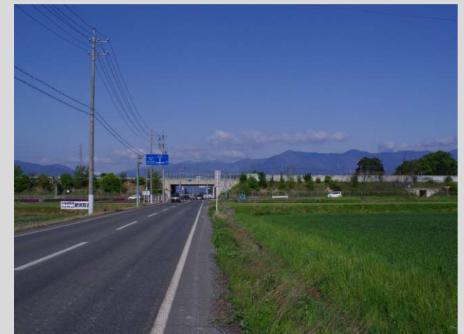
島立地区③ジャンクション東側から
