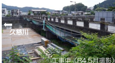
工事中 (R4.5月撮影)
