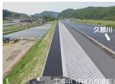
工事中 (R4.5月撮影)
