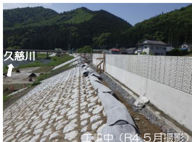
工事中 (R4.5月撮影)
