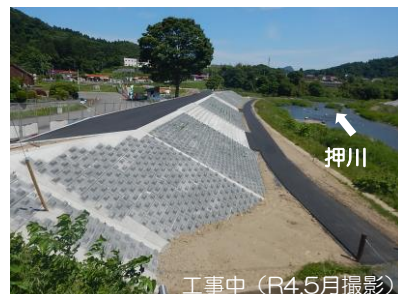
工事中 (R4.5月撮影)
