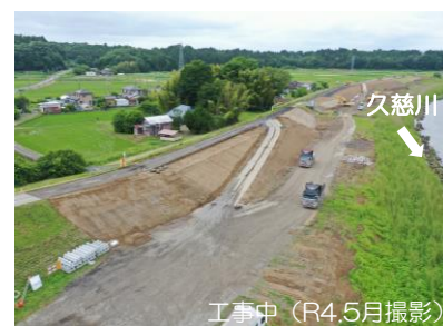
工事中 (R4.5月撮影)
