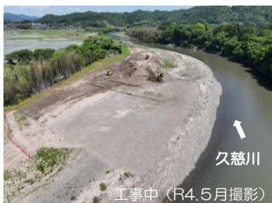
工事中 (R4.5月撮影)
