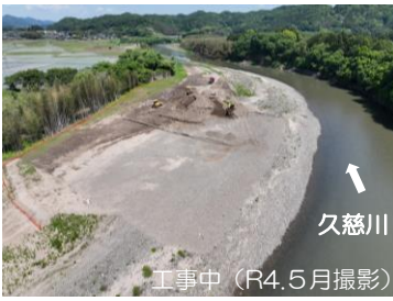
工事中 (R4.5月撮影)
