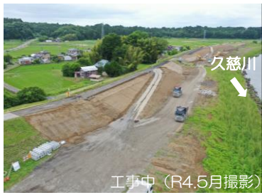
工事中 (R4.5月撮影)
