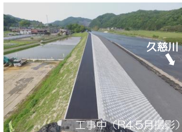
工事中 (R4.5月撮影)
