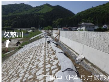
工事中 (R4.5月撮影)
