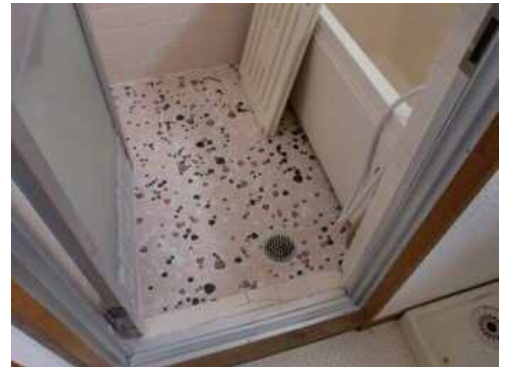
既存浴室 (ユニットバスに改修)
