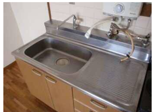
既存流し台 (混合水栓に改修)
