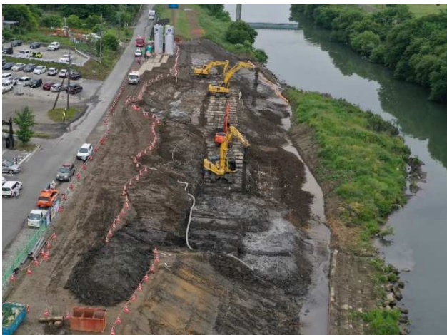
施工状況全景
