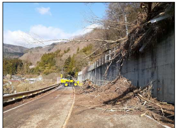
令和2年4月14日に発生した国道19号 長野市信州新町日原西の土砂流出被災状況
