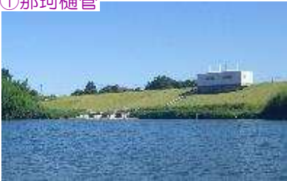
①那珂樋管
