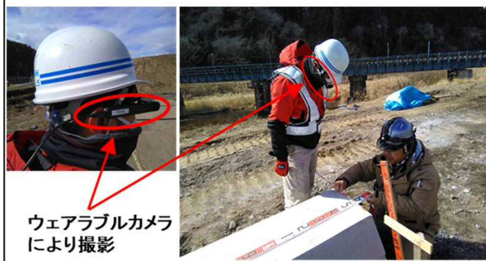
現場での受注者による撮影状況
