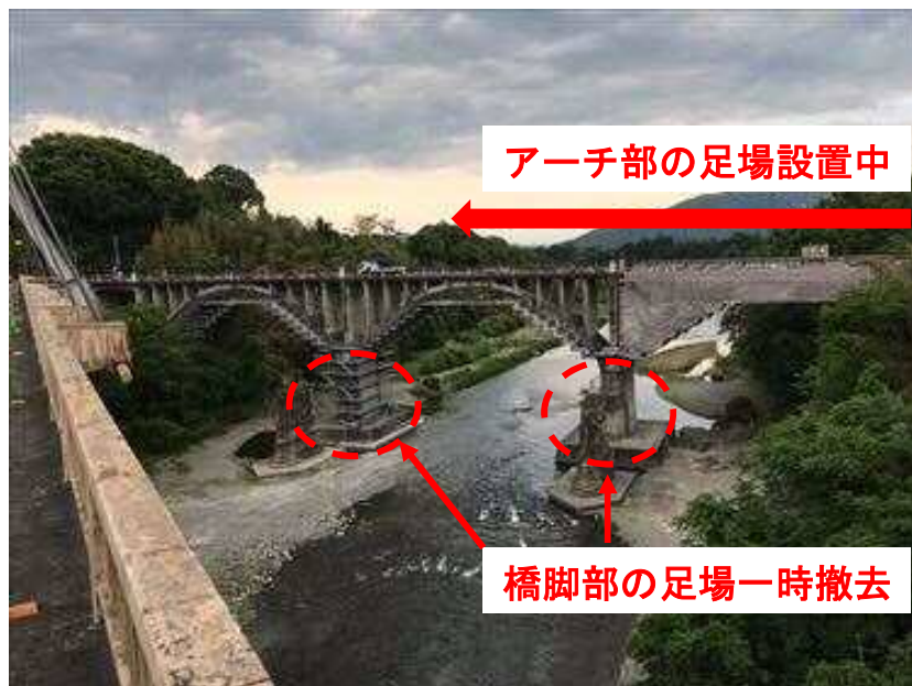
足場の作業状況
