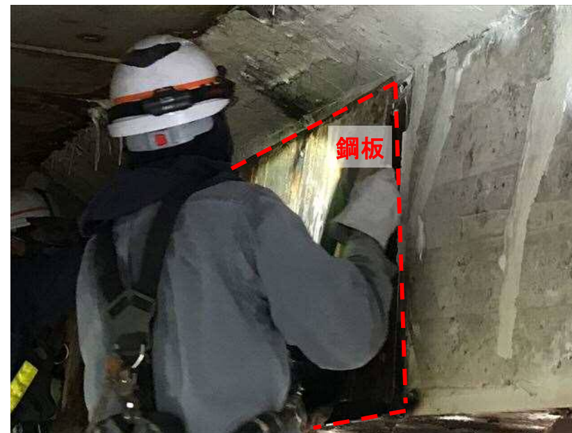
鋼板撤去の作業状況
