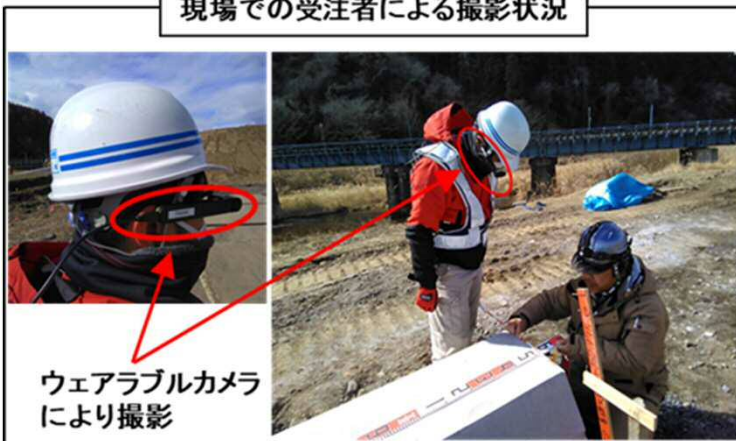
現場での受注者による撮影状況
