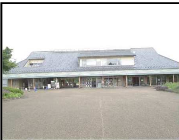
(砂川口管理棟 南側立面)
