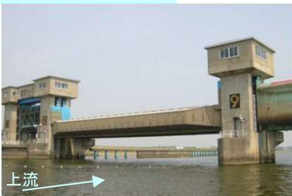
越流型シェル構造2段式ローラゲート
