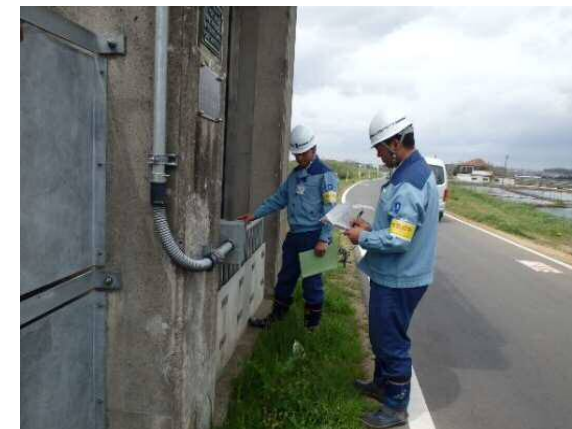
水資源機構職員による直営点検巡視 (水門・樋門等)
