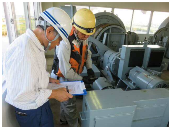
ゲート設備の点検(新利根河口水閘門)
