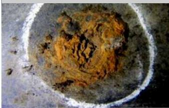
現場溶接部の腐食・塗膜ふくれ
