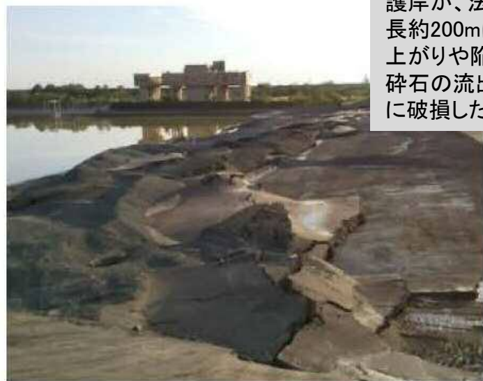
流入堤の被災状況
