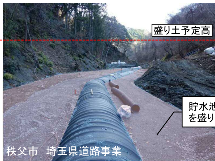
ダム下流での置土の設置
