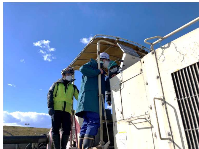
ICTスタビライザーのモニターで改良状況の確認
