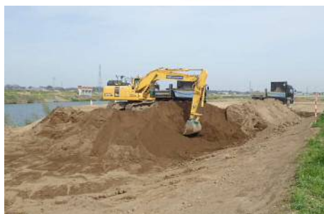
河道掘削の状況（渡里地区）
