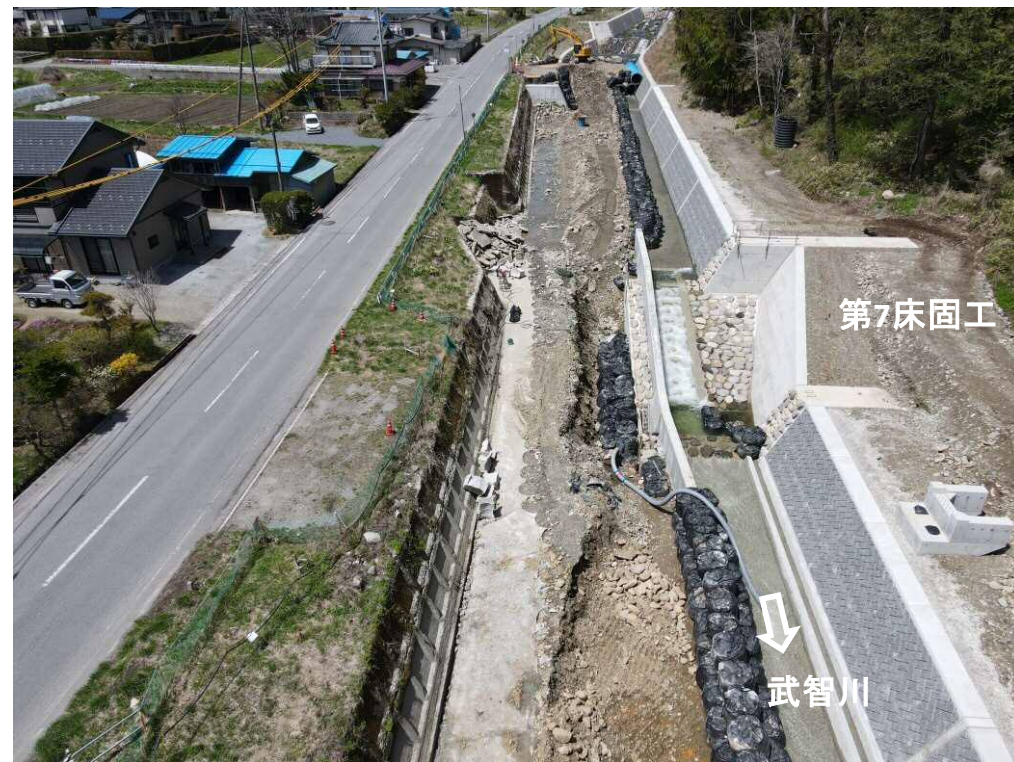
下流上空より施工箇所（第7床固工）を望む
