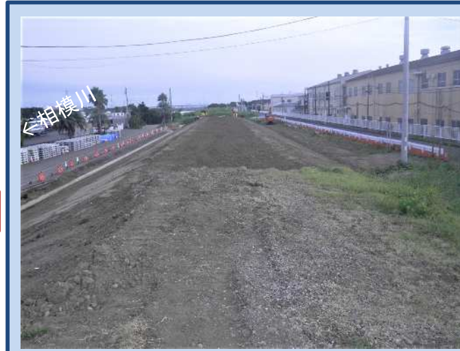
盛土を施工しています。 (令和4年8月)
