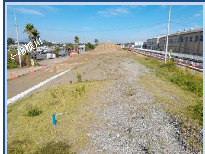
盛土を施工しています。 (令和4年10月)
