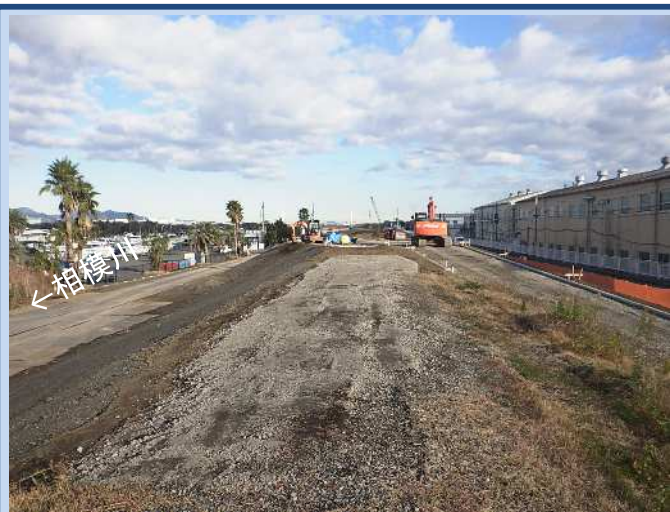
坂路舗装を施工しています。 (令和4年12月)
