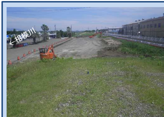
工事に入る準備をしています。 (令和4年6月)
