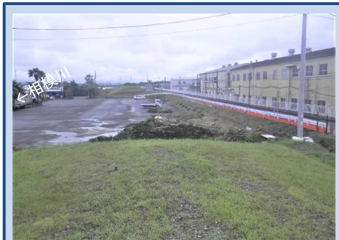
工事に入る準備を行っています (令和4年5月)
