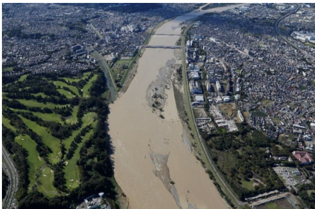
工事箇所付近における 令和元年東日本台風通過後の状況
