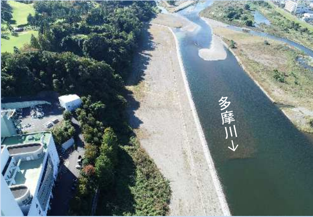
工事着手前(令和4年10月)
