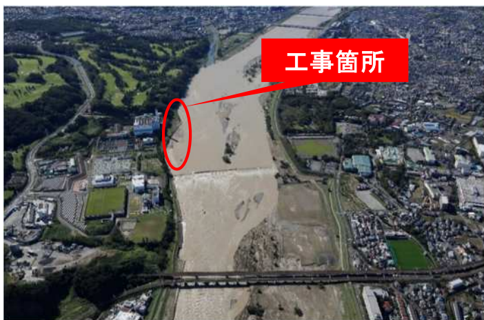
工事箇所付近における 令和元年東日本台風通過後の状況
