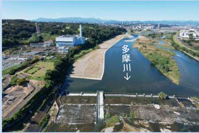
工事着手前(令和4年10月)
