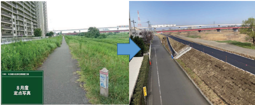
R2多摩川右岸日野築堤工事
