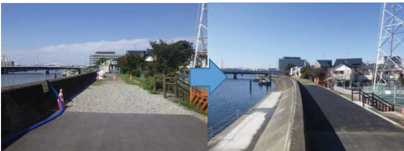
R2鶴見川左岸栄町通四丁目地区耐震堤防工事
