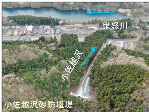
小佐越沢 小佐越沢砂防堰堤
