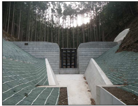
小佐越沢砂防堰堤(完成)
