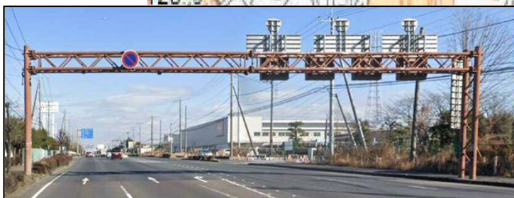
撤去する門型標識
