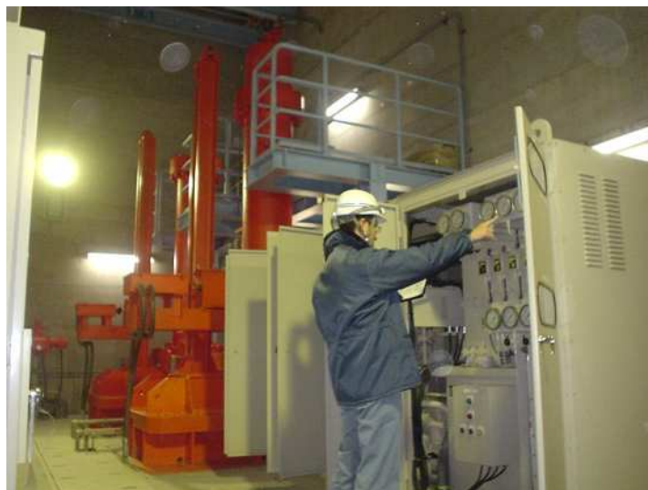
ダム放流設備点検の状況
