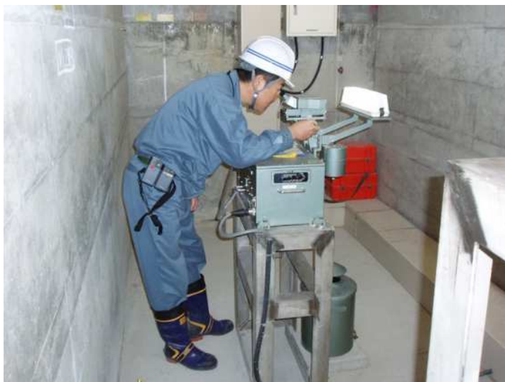
ダム堤体 コンクリート点検の状況
