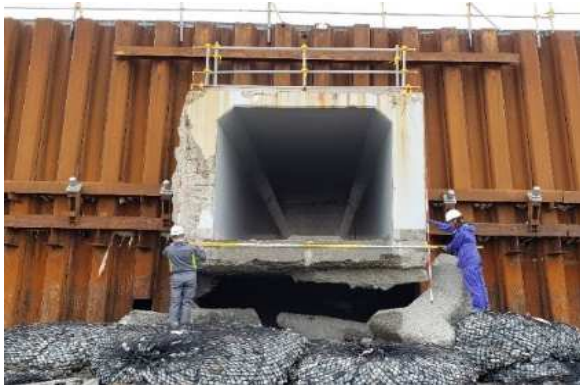
被災直後の状況(西湘バイパス路面下の破損)
