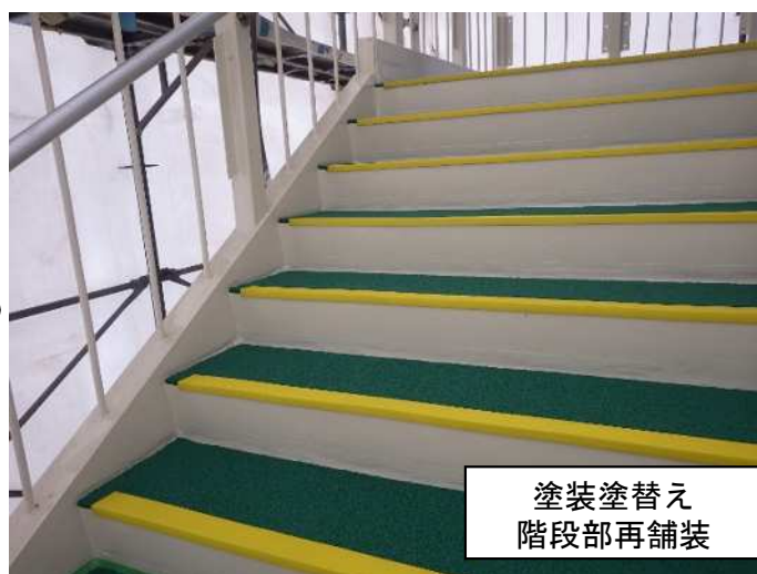
まつばら 【国道1号 松原歩道橋における補修事例】
