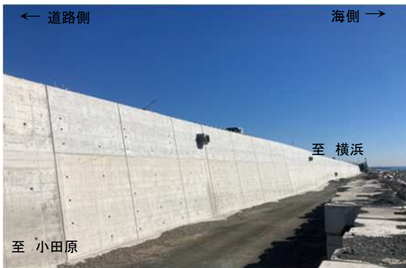
補強土壁(護岸)の設置状況(令和4年2月撮影)
