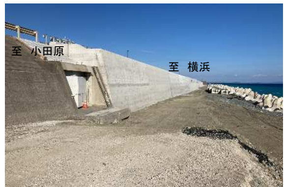
波除ブロック(仮設)の設置状況(令和4年2月撮影)
