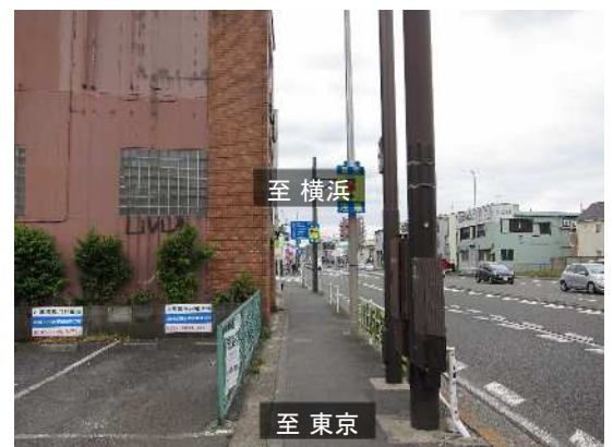
【歩道整備前の状況】 (川崎市幸区遠藤町 下り線)
