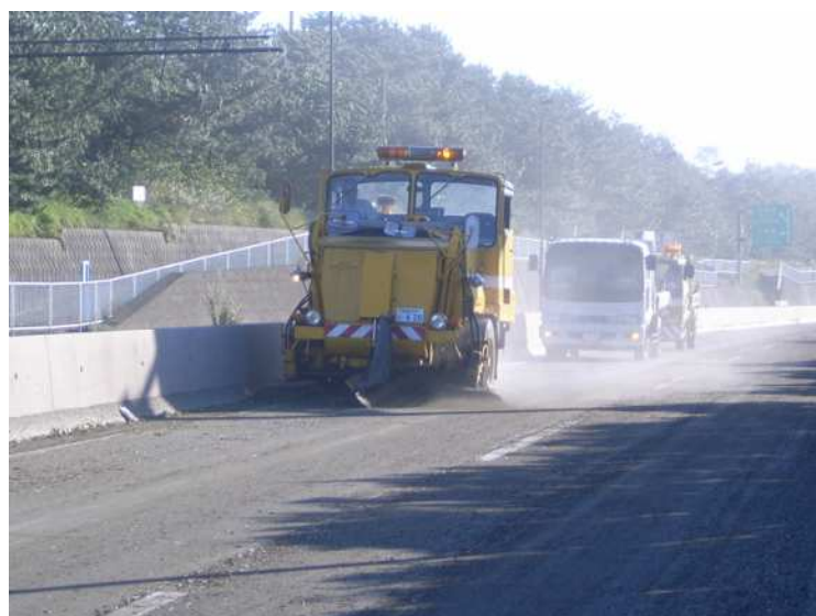
台風後の路面清掃 (国道1号西湘バイパス)
