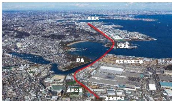
【夏島地区付近(令和4年2月撮影)】
