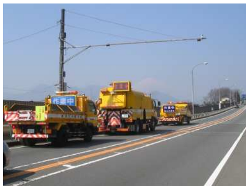
清掃 (路面清掃・排水施設清掃等)
