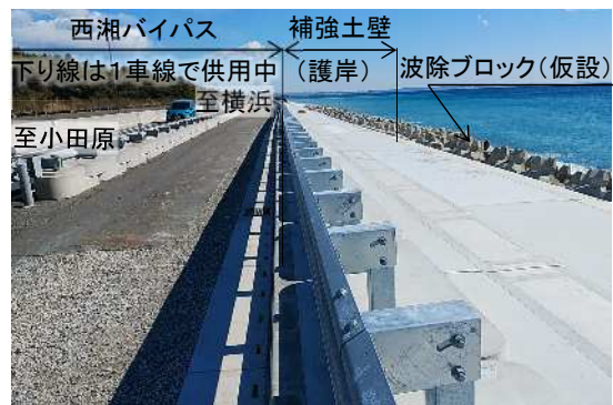
現場復旧状況(令和4年2月撮影)
