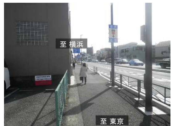
【歩道整備後の状況】 (川崎市幸区遠藤町 下り線)
