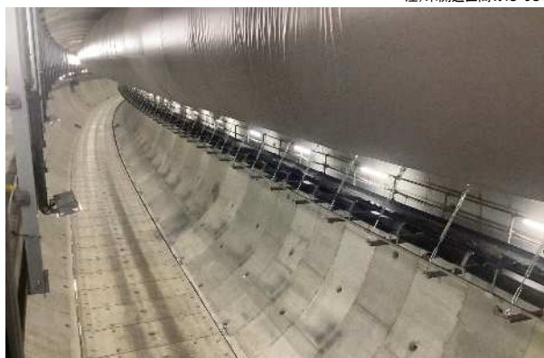
【トンネル工事状況(令和4年4月撮影)】
