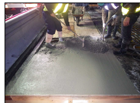
▲床版架替状況 (コンクリート打設)
