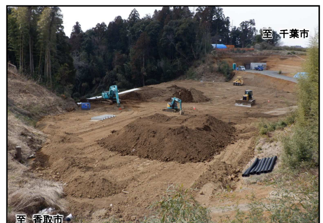
写真: 工事状況 (桜田地区)
