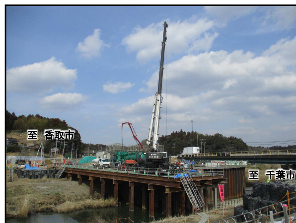
写真: 工事状況 (東金山橋)
