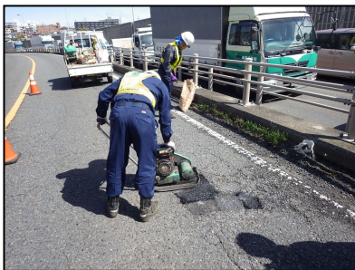
路面補修状況
