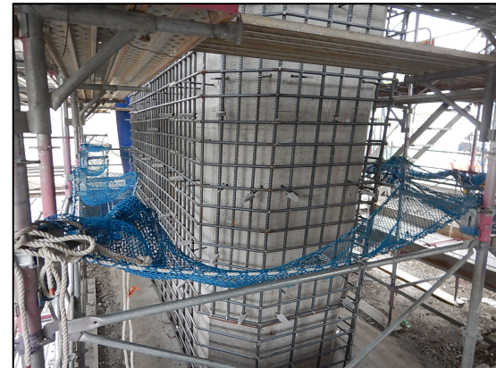
コンクリート巻立による橋脚補強
