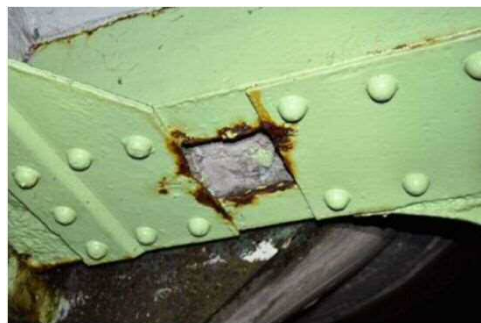
&lt;縦桁部分補修&gt;
