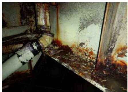
&lt;主桁部分補修&gt;
