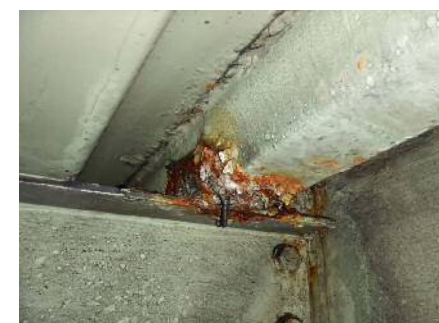
&lt;床版部分補修&gt;
