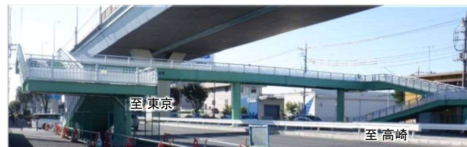
西堀歩道橋完成後
