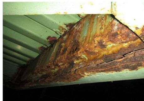
&lt;横桁部分補修&gt;
