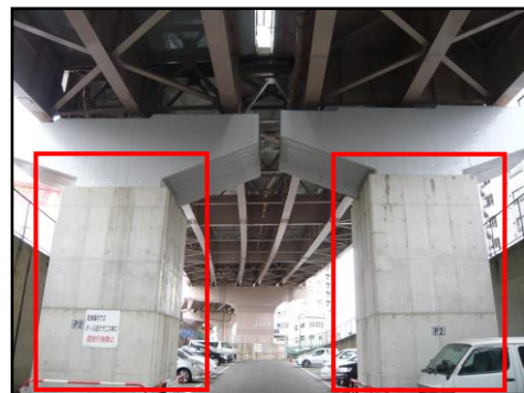
コンクリート巻立による橋脚補強
