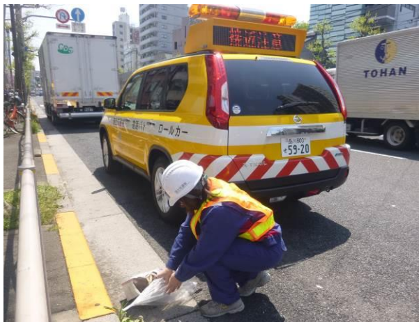
道路巡回パトロール
