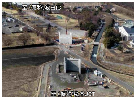
はた 波田地区の工事状況
