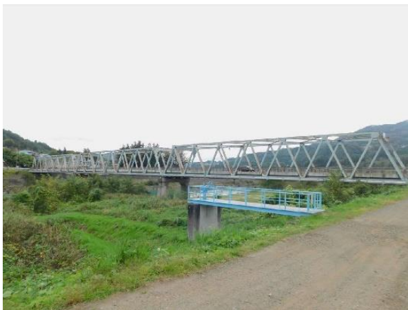
橋梁状況(全景)
