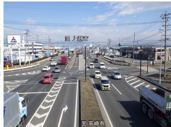
国道18号大塚交差点付近の状況
