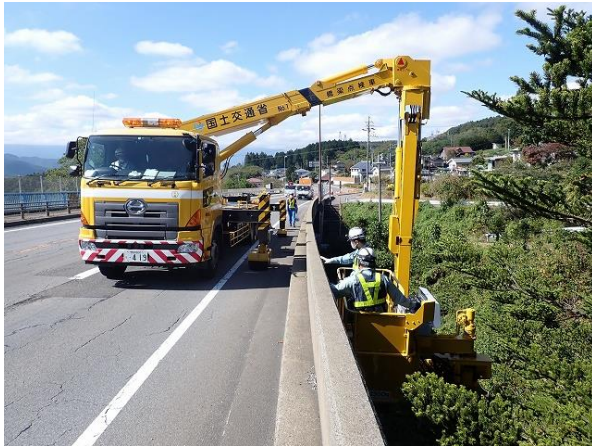
点検状況(遠景)
