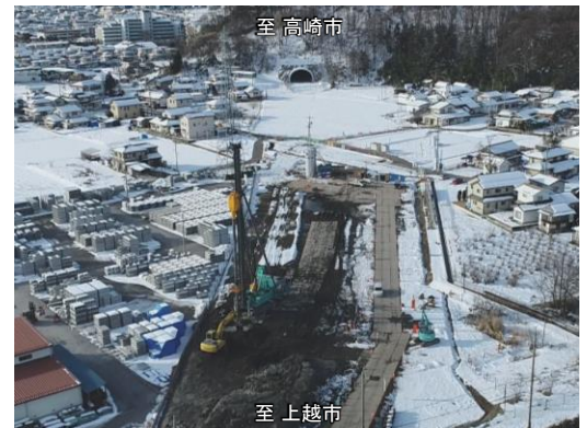
長野市塩崎地区の工事状況
