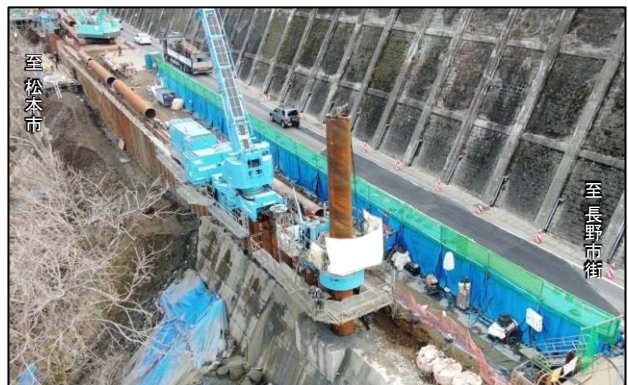
復旧工事の実施状況(令和4年4月)
