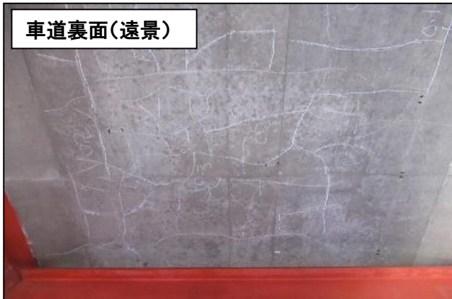
車道裏面(近景)
