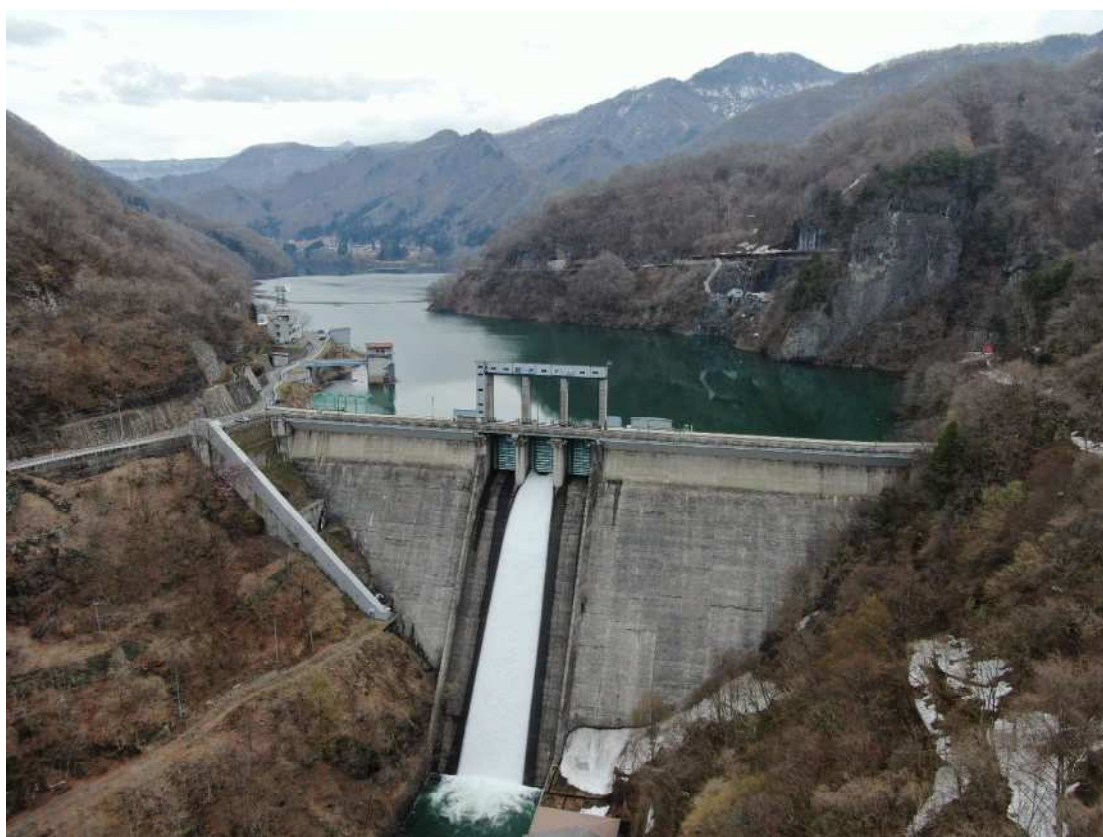
藤原ダム上流域の状況（令和4年4月18日撮影）
