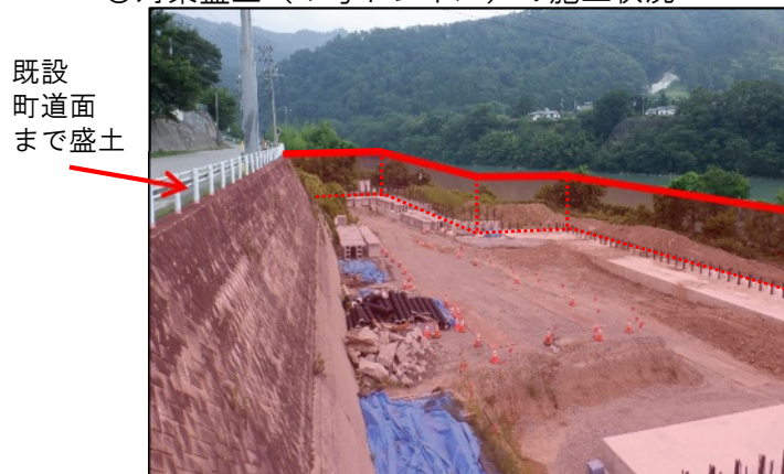
○対策盛土（1号トンネル）の施工状況
