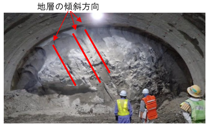
山清路1号トンネル切羽写真
