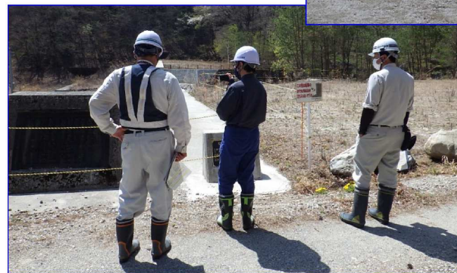
▲尾白川流域の点検状況
