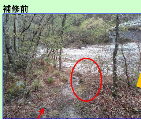
立入禁止看板未設置 危険箇所へ進入して 転落する危険性あり。
