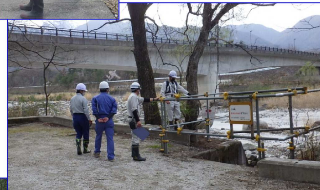
▲大武川流域の点検状況▲
