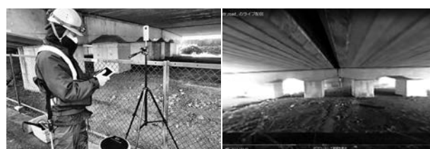
撮影状況 写真－3 B橋・桁下の状況（全方位カメラ映像）
