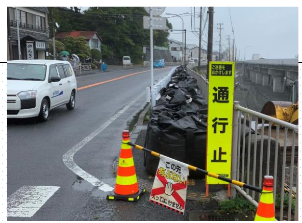
■ 通行止めの状況
