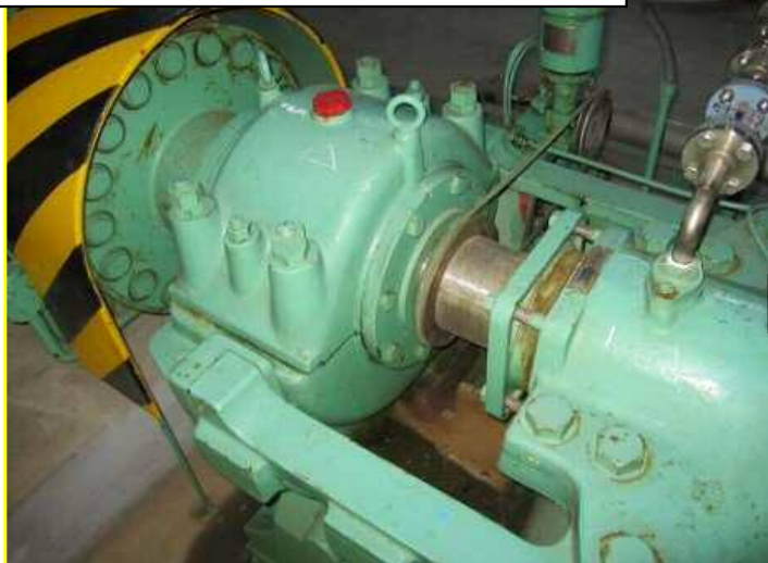
現状のポンプ軸封部（グランドパッキン）
