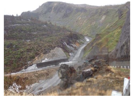
上流の荒廃状況
