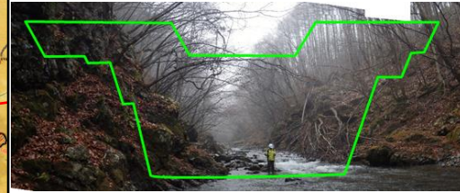
片品上流第二砂防堰堤
