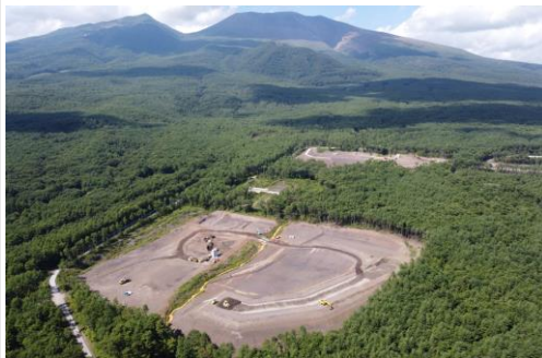
濁川第一砂防堰堤
