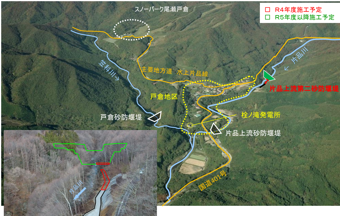
片品上流第二砂防堰堤施工箇所
