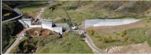
振子沢砂防堰堤
