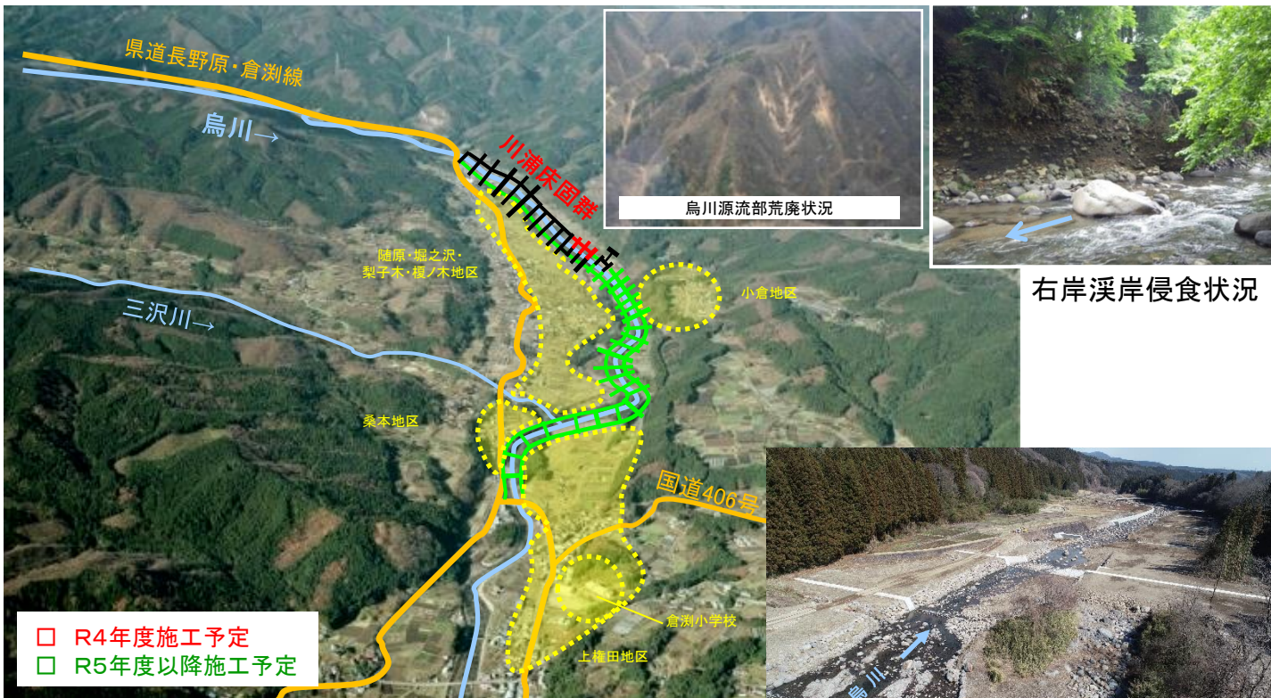
川浦床固群周辺の状況
