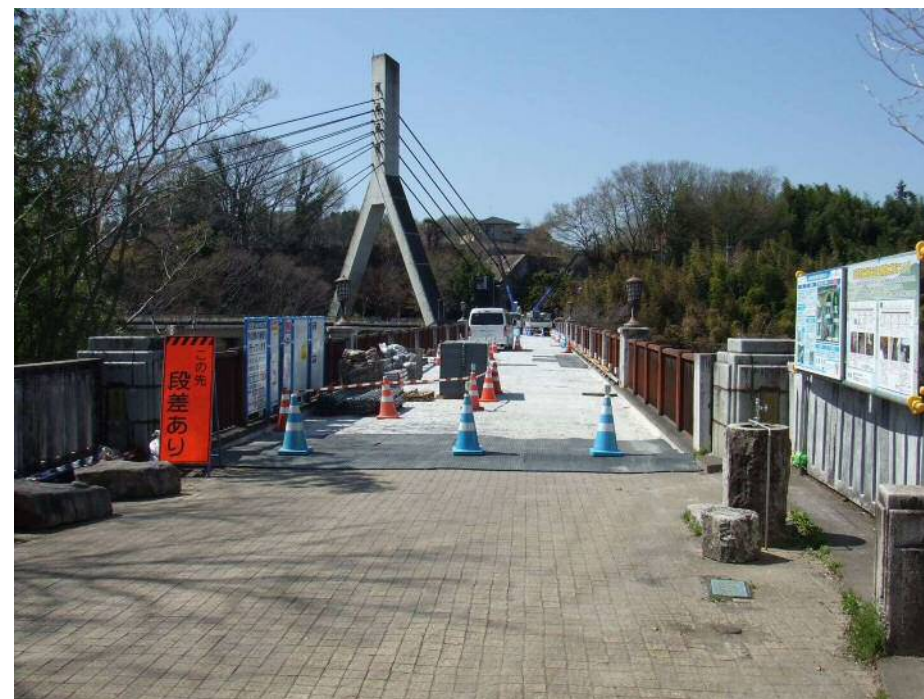
橋面上の作業状況
