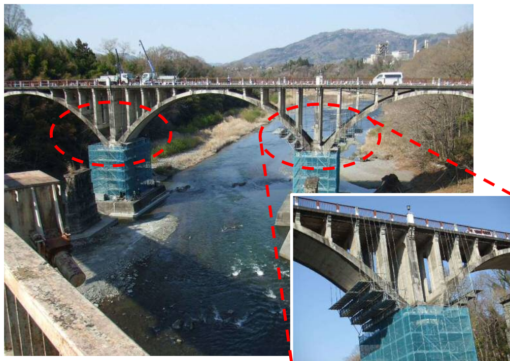
アーチ部の足場設置の状況
