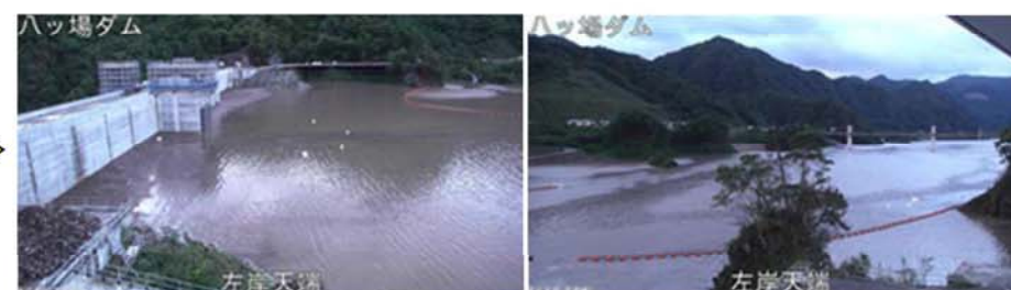
10月13日 6:00(EL.573.9m) 状況写真
