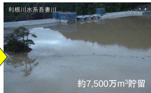
10月15日 17:00 状況写真
