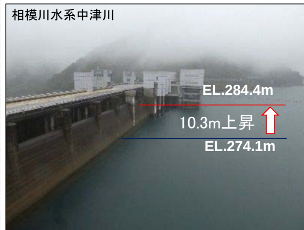
10月12日 8:00 状況写真
