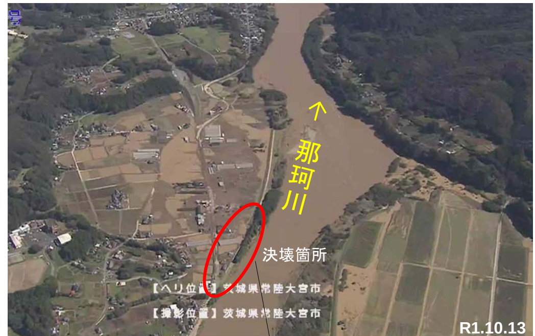
那珂川水系 那珂川左岸40.0k付近
