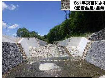
武智川下流床固群 施工完了箇所
