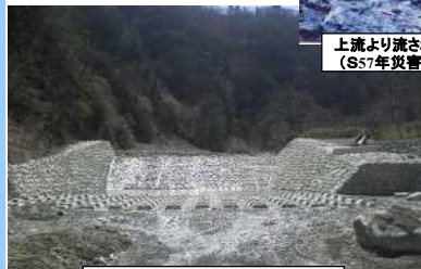
小武川下流床固群 施工完了箇所
