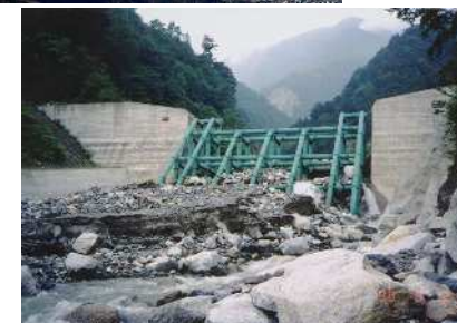
砂防堰堤(透通型):大瀬沢第二砂防堰堤
