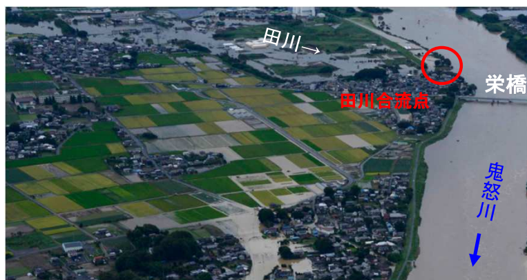
平成27年9月関東・東北豪雨における田川流域の 浸水状況 (H27.9.10 16時撮影)
