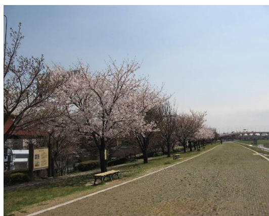
写真 7-3 足立区江北地区（桜つつみ整備）
