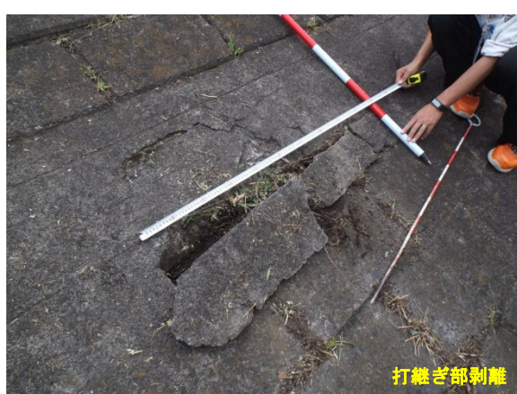
写真 3-1 高潮堤防の老朽化の状況
