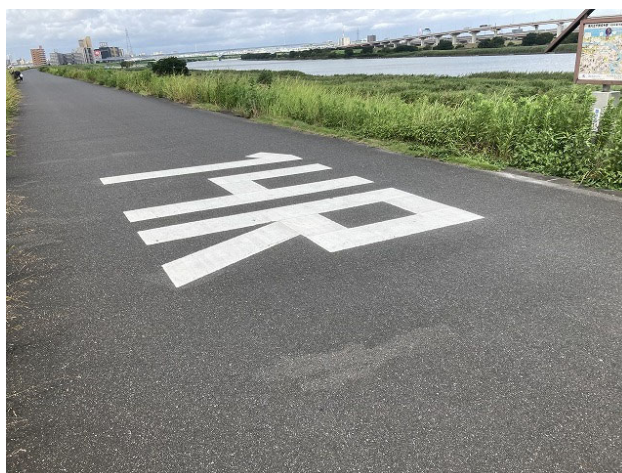
写真 6-2 対空標示（ヘリサイン）
