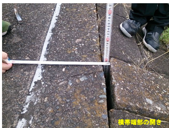
写真 3-1 高潮堤防の老朽化の状況
