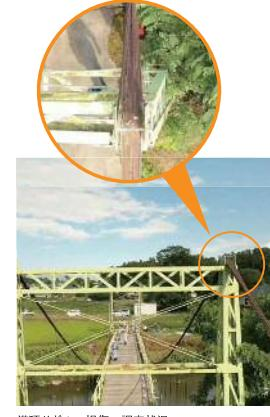
塔頂サドルの損傷の調査状況
